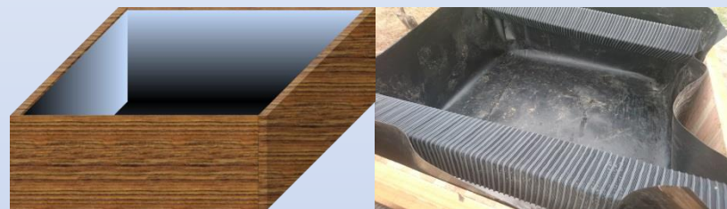
2. 護欄內鋪設不透水布
