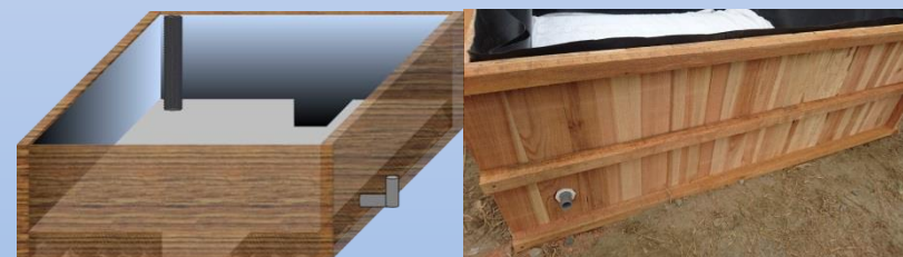
6. 安裝進水管及溢水管
